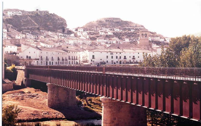
PUENTE DE HIERRO DE GALERA | FOTO: ARCHIVO HISTÓRICO MUNICIPAL
